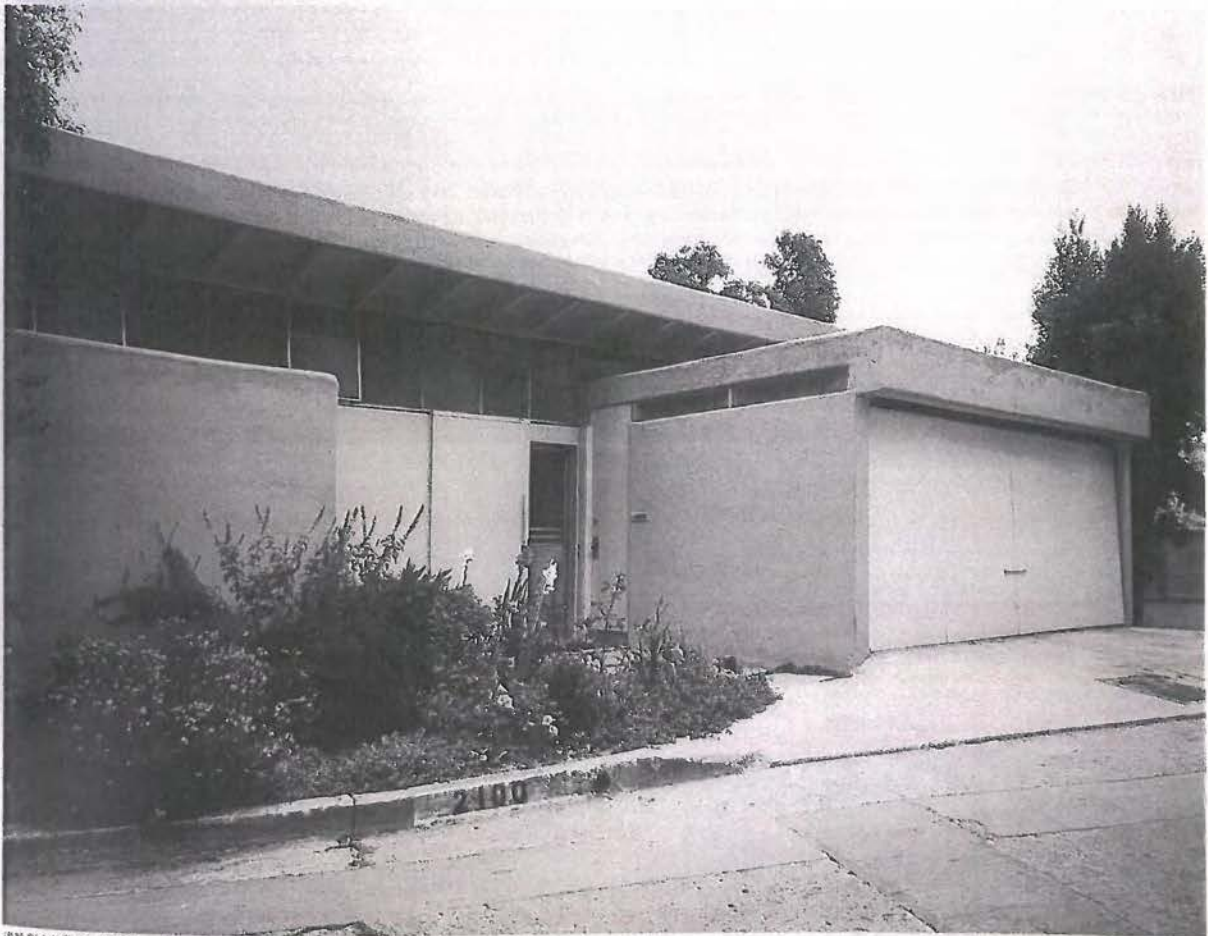
道路側より見る。右がガレージ
