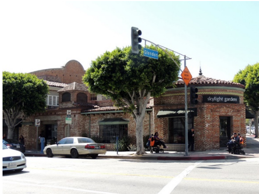
Address: 1139 S. Glendon Avenue Name: La Ronda de las Estrellas Architect: Conway & Wilson Date: 1933
