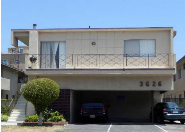
3626 S. Vinton Avenue, Palms, 1963 (SurveyLA)
